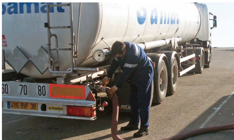
Déchargement du glycol dans le réseau.
